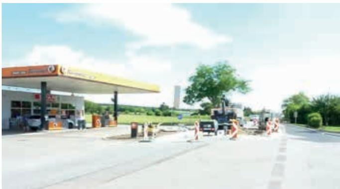
In Wienerherberg wird bei der Tankstelle eine Querungshilfe für den Fußgängerverkehr errichtet (siehe Bild oben). Zudem wurde die maximale Höchstgeschwindigkeit mit 50 km/h verordnet.
