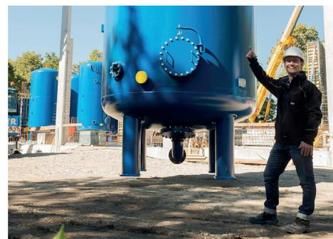
Die Arbeiten für die Naturfilteranlage in Wienerherberg laufen auf Hochtouren. Die tonnenschweren Filter wurden bereits aufgestellt.
