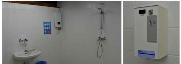
Da wir den Strom teilweise selbst über die PV Anlage produzieren wurden auch die Duschräume saniert und ein elektrischer Durchlauferhitzer installiert. Damit gibt es zukünftig auch die Möglichkeit warm zu duschen. Die Münzen für den Duschautomat können an der Badkassa gegen ein Entgelt von 50 Cent bezogen werden.
